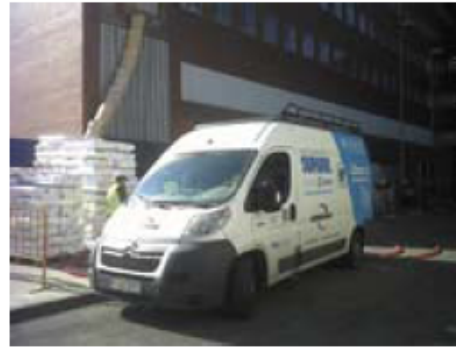
Rehabilitación del Hospital General de Vic (Barcelona) con soluciones de Supafil
