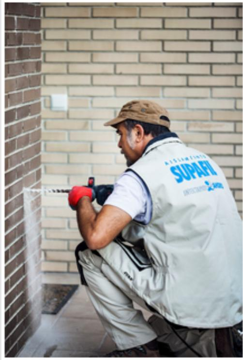
3. Se lleva a cabo la inyección de la Lana Mineral **Supafil 034** a través de la manguera en los orificios efectuados. Durante el insuflado se lleva a cabo un control de calidad en tiempo real para garantizar la óptima distribución del producto.
